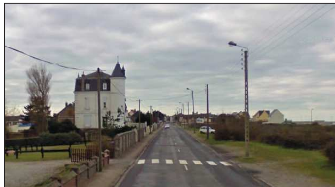
Photo 2bis : Photo de la RD 102 au début de ce tronçon en l'état actuel, au même point que la photo 2
