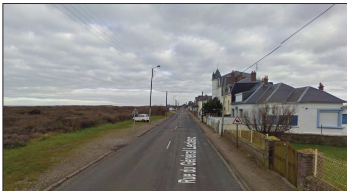
Photo 1bis : Photo de la RD 102 au début de ce tronçon en l'état actuel, au même point que la photo 1
